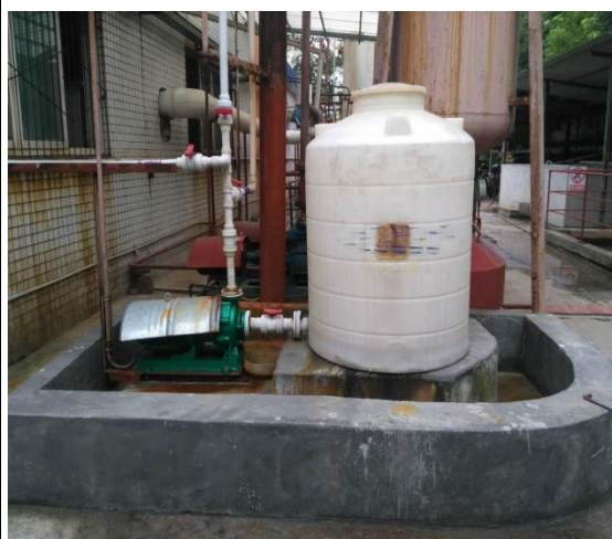
图 3-2 储罐及地面防护情况
